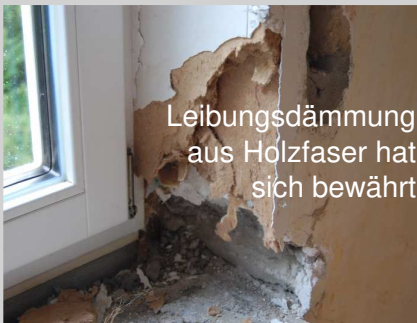
Rückbau der Betonfensterbank
