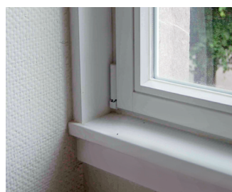
Abb. 2: Fenstertausch im Denkmal. Neue Eichenfenster in Vollziegelmauerwerk mit Sandsteingewände. Gegen Schimmel an kalten Oberflächen in
